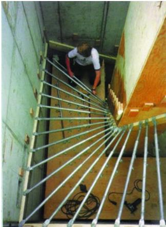
Durch den Einsatz des sicheren feststellbaren Teleskopstabes ist ein zusätzliches mittiges Unterstützen der Treppenlaufschalung nicht erforderlich.
