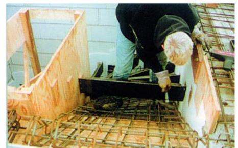
Die ausziehbaren Treppenstufen werden mit 65er Nägeln an den Stufenlaschen befestigt.
