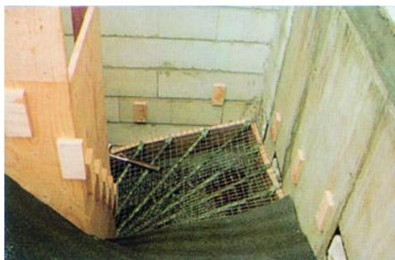
Der Fixophon-Belag wird auf das Wellengitter aufgelegt und passend zugeschnitten. Die seitl. Befestigung erfolgt mit Pappstiften auf den Holmen und in den Flächen mit Bindendraht.
