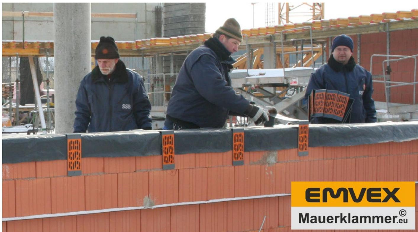
Die Mauerklammer verhindert das ungewollte Eindringen von Niederschlagswasser in das Mauerwerk während der Bauphase. Sie löst das ewige Nässeproblem und garantiert zusammen mit der passenden Abdeckfolie den Nässeschutz für **alle Größen von Mauerziegeln und Mauersteinen** und das bei allen Wetterlagen von Baubeginn an.
